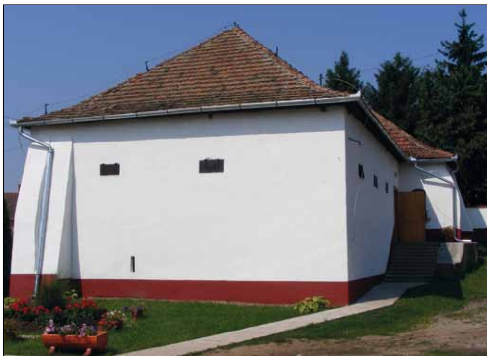
Az épület keleti és északi homlokzata napjainkban
